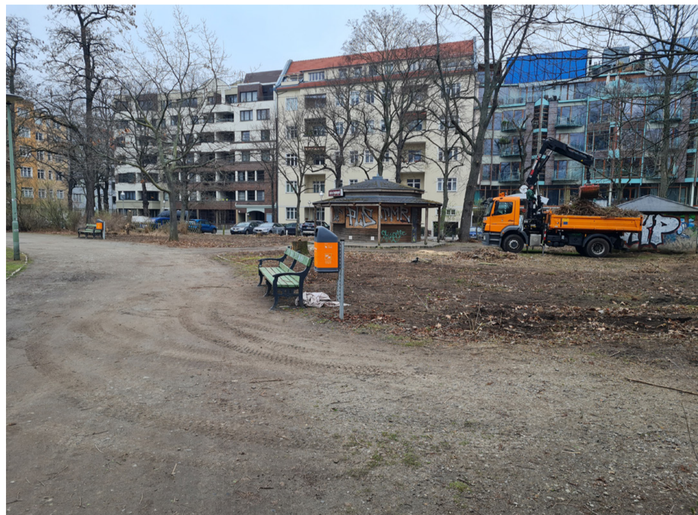
Bauvorbereitenden Arbeiten auf dem Hangspielplatz im Preußenpark Foto: Büro Sandra Khalatbari
